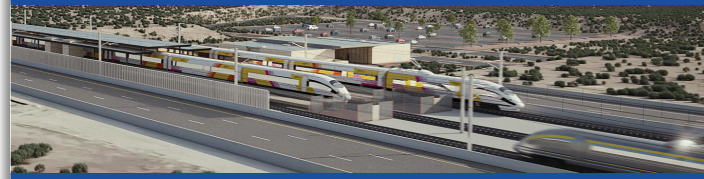
REPRESENTACIÓN DE LA ESTACIÓN DE TREN DE ALTA VELOCIDAD DE VICTOR VALLEY
